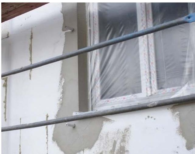
Importante: non utilizzare MasterEmaco ADH 290 su polistirene estruso con pelle o pannelli termoisolanti rivestiti con film di plastica o carta
